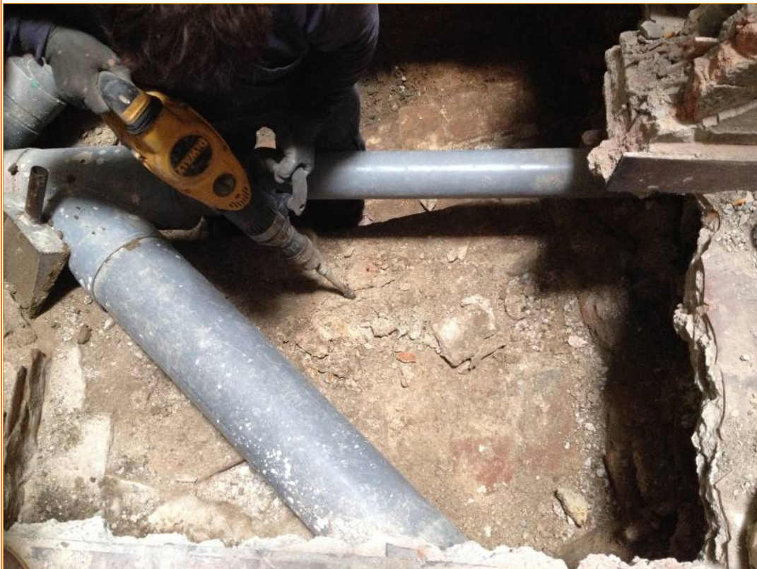
Foto 6. Treballs d'enderroc del paviment UE 3 a la part central.
