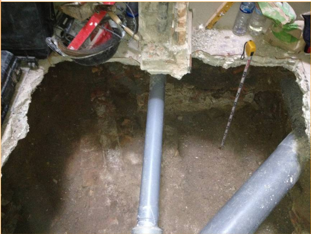
Foto 12. Vista general des de l'est del fossat de l'ascensor un cop finalitzades les obres.
