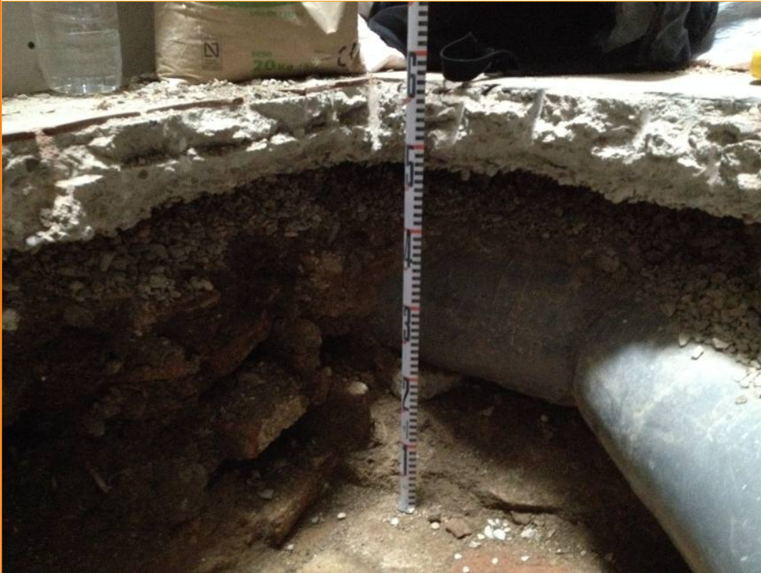
Foto 1. Paviment UE 1 i claveguera UE 2 a l'angle sud-est.
