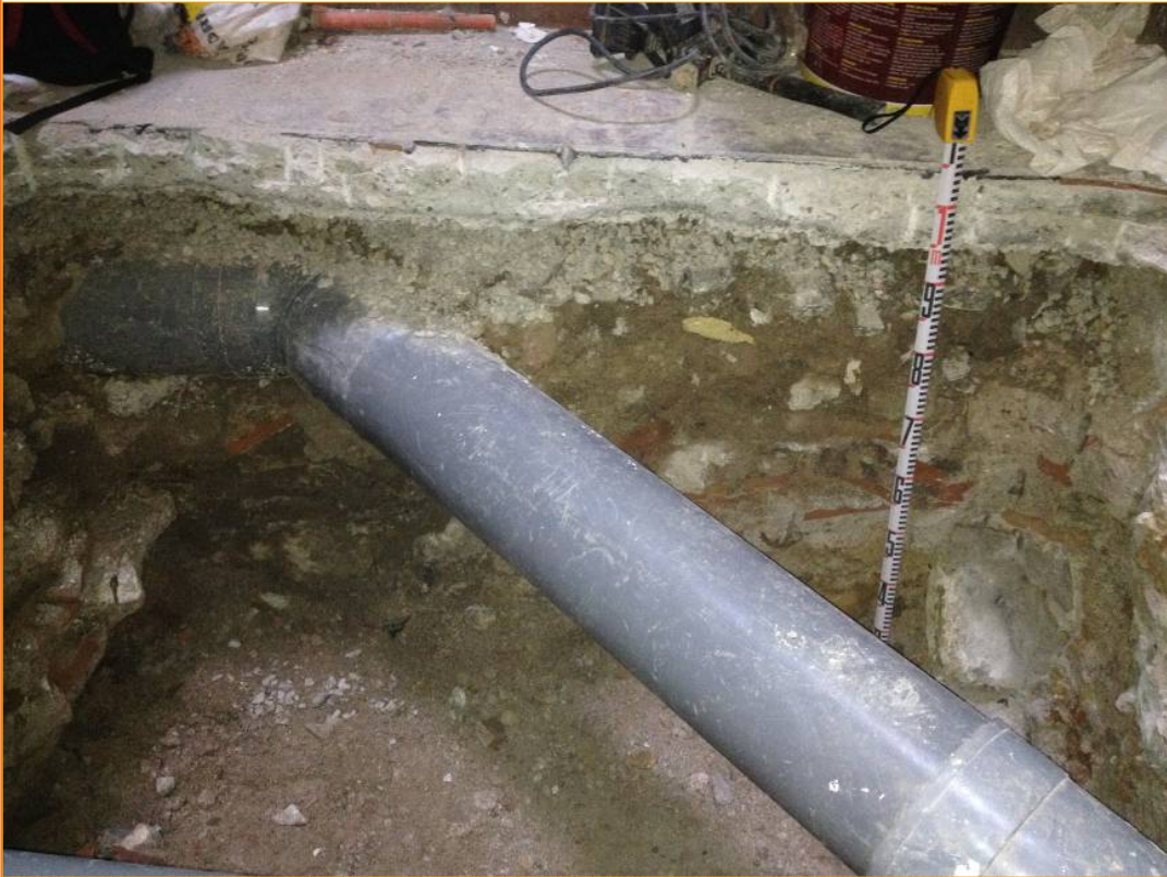
Foto 9. Estat final del perfil sud un cop finalitzades les obres.
