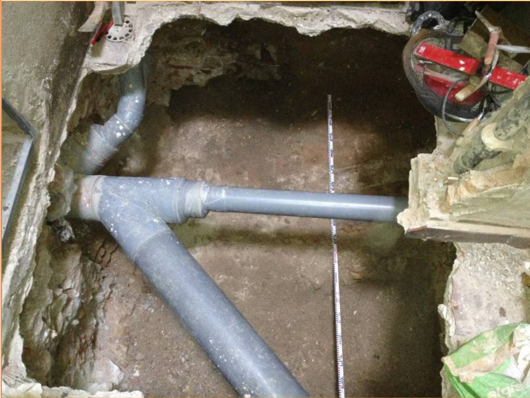
Foto 11. Vista general des del sud del fossat de l'ascensor un cop finalitzades les obres.
