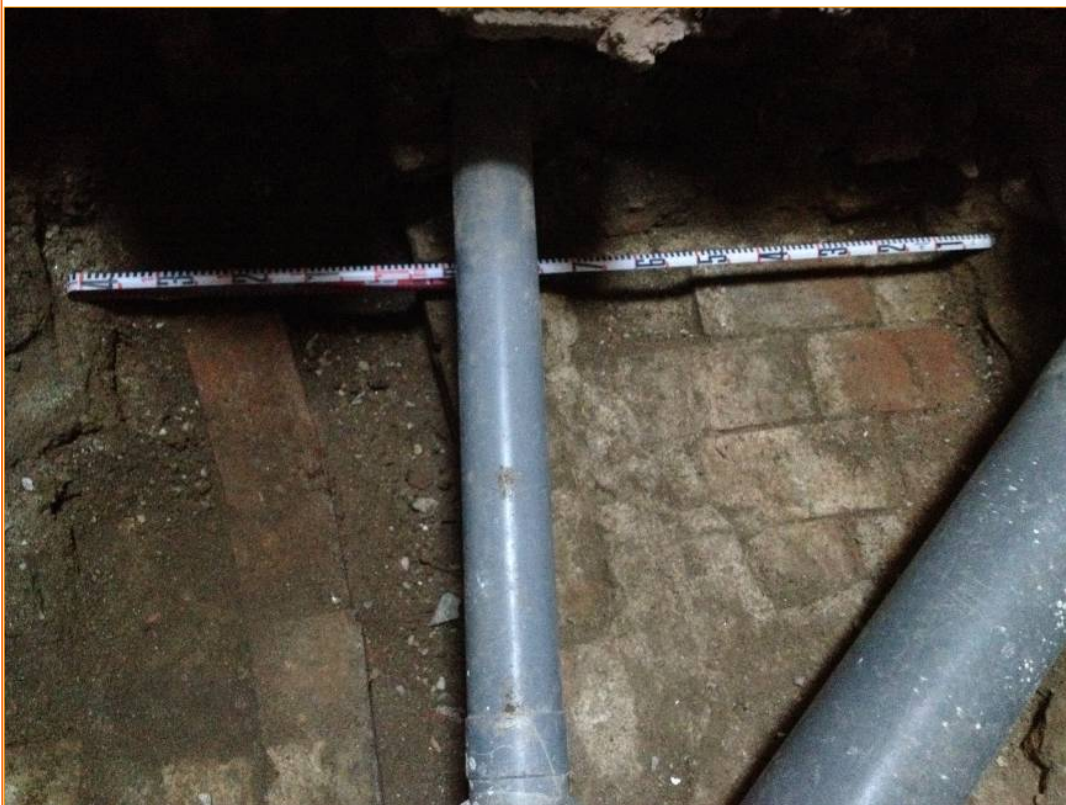
Foto 2. Claveguera UE 4, farciment UE 5 i el paviment UE 3.
